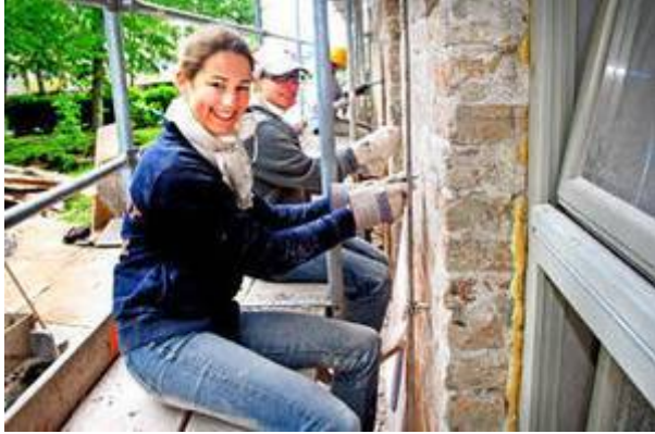
Julia Rost und Franziska von Arnim kratzen den maroden Putz von der Fassade des Gutshauses. (Foto: Anke Rutkowski)
