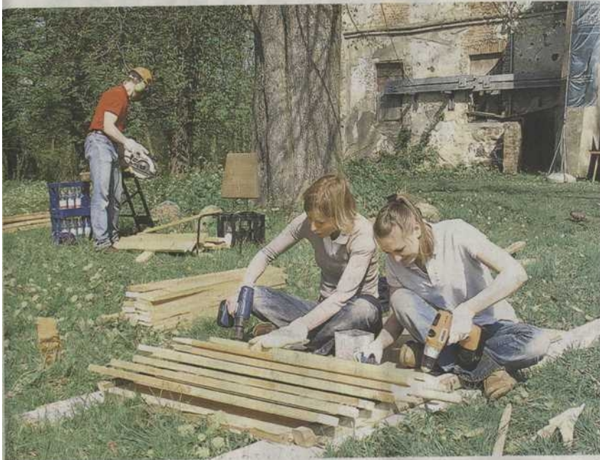
Ricarda Gerke (27/r.) und Valerie Reck (29) schrauben bei Traumwetter vor dem Quilower Wasserschloss aus Brettern Luftschotte für die Fensterlöcher im Gutshaus zusammen, die Timo Voswinckel zurechtgesägt hat.
